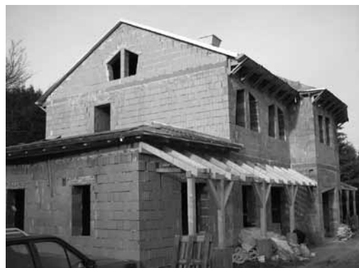
A magyarországi Velemben épülő Camphill lakóotthon építése (balra).
